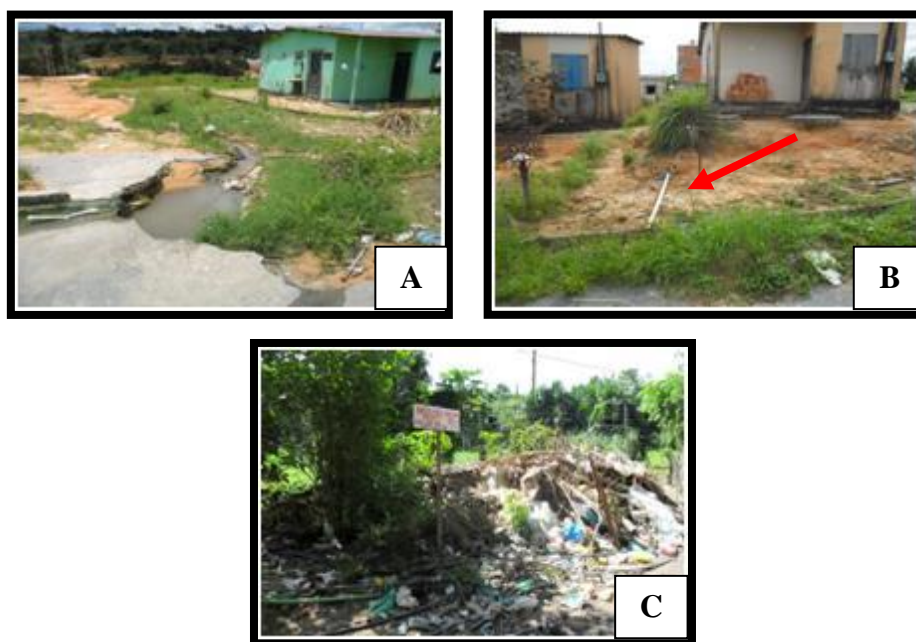
Figura 4: Infraestrutura do Conjunto João Paulo II, Manaus-AM. A - Esgoto a céu aberto. B – Ausência de pavimentação nas calçadas, vegetação toma conta das ruas e tubulações de água expostas a resíduos fecais. C - Presença de lixo por todo o Conjunto João Paulo II
